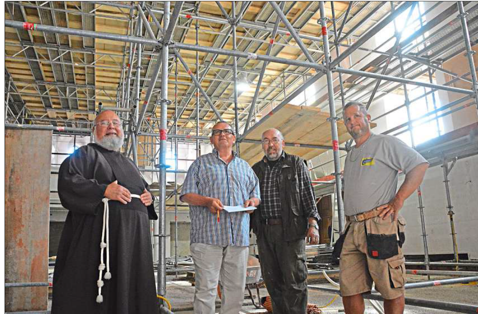
Sind bislang mit dem Baufortschritt zufrieden: (von links) Guardian P. Norbert Schlenker, Gesamtbauleiter Manfred Schwaiger, Br. Ägidius Schönsmaul, der auf der Baustelle Ansprechpartner für die Handwerker ist, und Vorarbeiter Robert Thielscher von der Firma Pfungstl in Burgkirchen.
