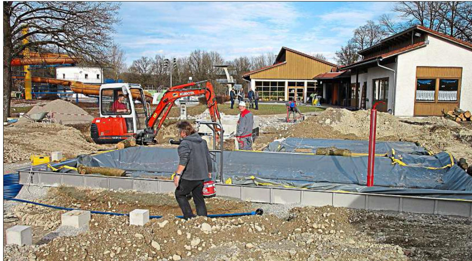
In eine Baustelle hat sich das Planschbecken im Freibad verwandelt. Die neuen Edelstahlbecken sind hier mit grauer Folie abgedeckt. Das Wasservolumen wird unverändert bleiben, aber die Form ist neu. – Foto: Gerlitz
