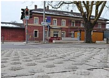
Im Bereich der Ampel existiert das Blindenleitsystem bereits. Im Zuge der Revitalisierung des Bahnhofs wird es bis in die Schalterhalle und zum Bahnsteig fortgeführt. – Fotos: sh
