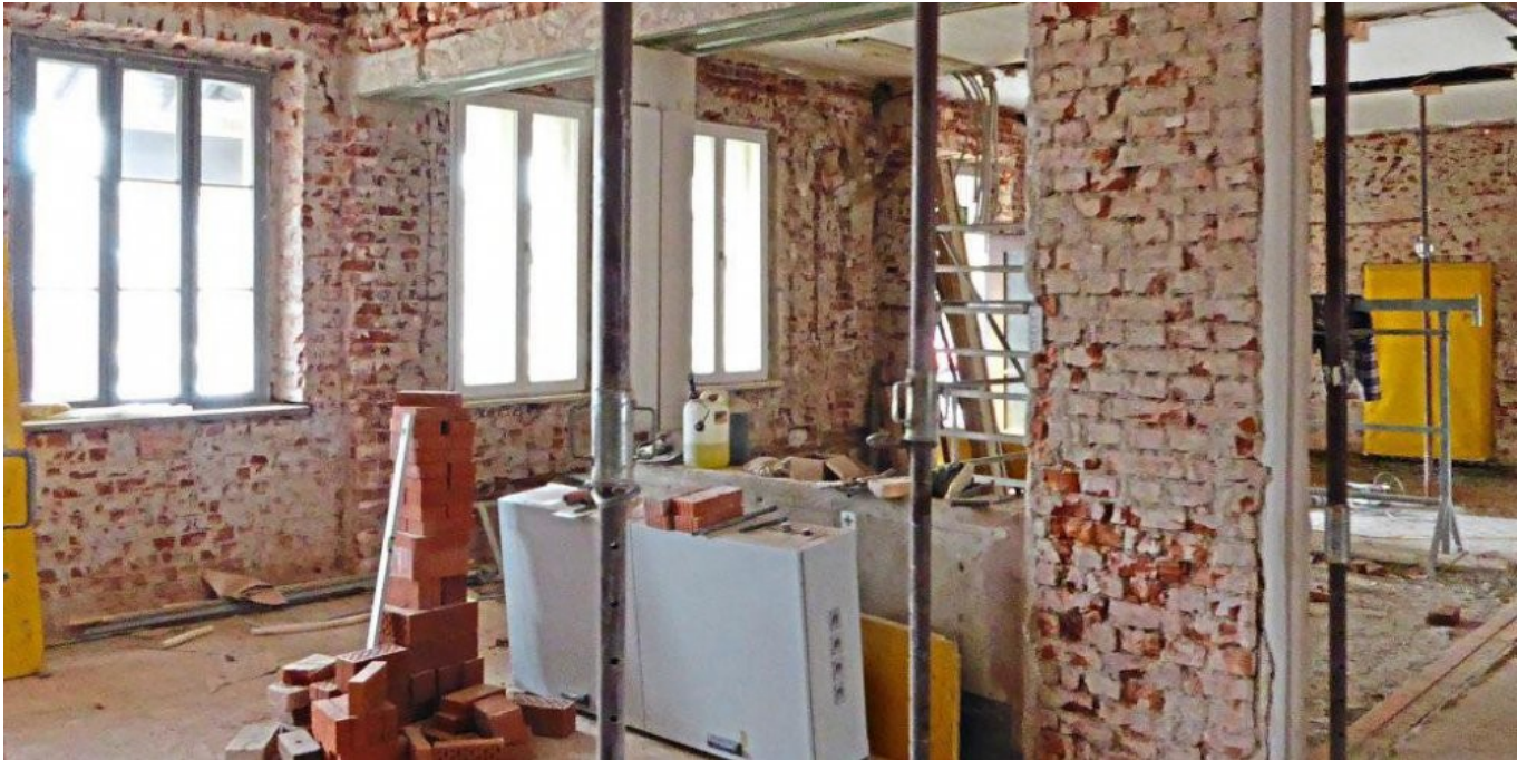
Kaum mehr wiederzuerkennen: Hier wurden bis Ende vergangenen Jahres noch Tickets verkauft. Jetzt sind bereits die Arbeiten angelaufen, der Putz ist von den Wänden geschlagen.
