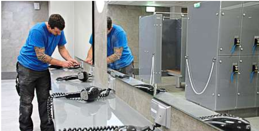
Letzte kleine Arbeiten wurden in den vergangenen Tagen noch erledigt.
