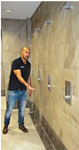
Bäderleiter Markus Günthner überprüft die neuen Duschen.
