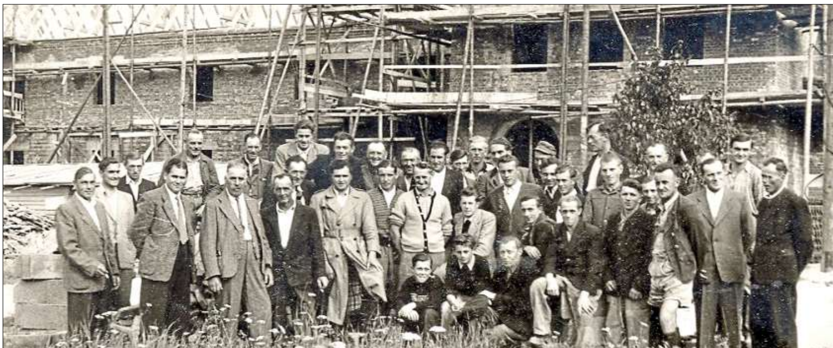
Anfang der Fünfzigerjahre wurde das Schulgebäude in der Burgkirchner Ortsmitte gebaut. Hier die Firstfeier mit August und Johann Pfingstl (dritter und vierter von links vorne). – Fotos: Archiv Pfingstl
