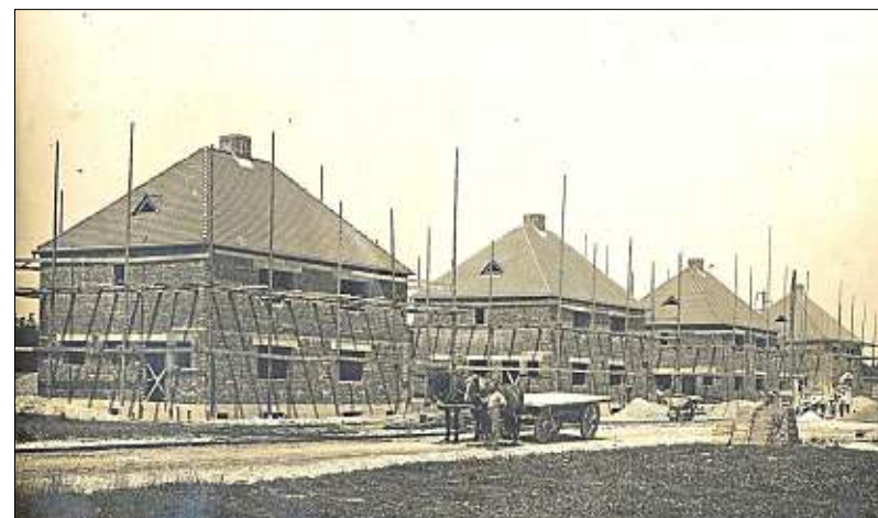
Beim Bau der Wackersiedlung im Jahr 1935 in Burghausen.
