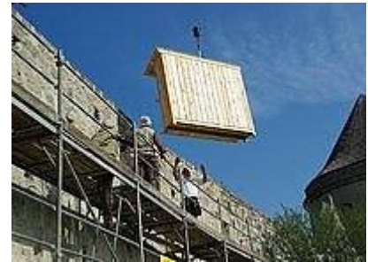
Mit Hilfe eines Krans wurden die hölzernen Brutkästen an ihrem Standort an der Wehrmauer fixiert. – Foto: P. Przesang
