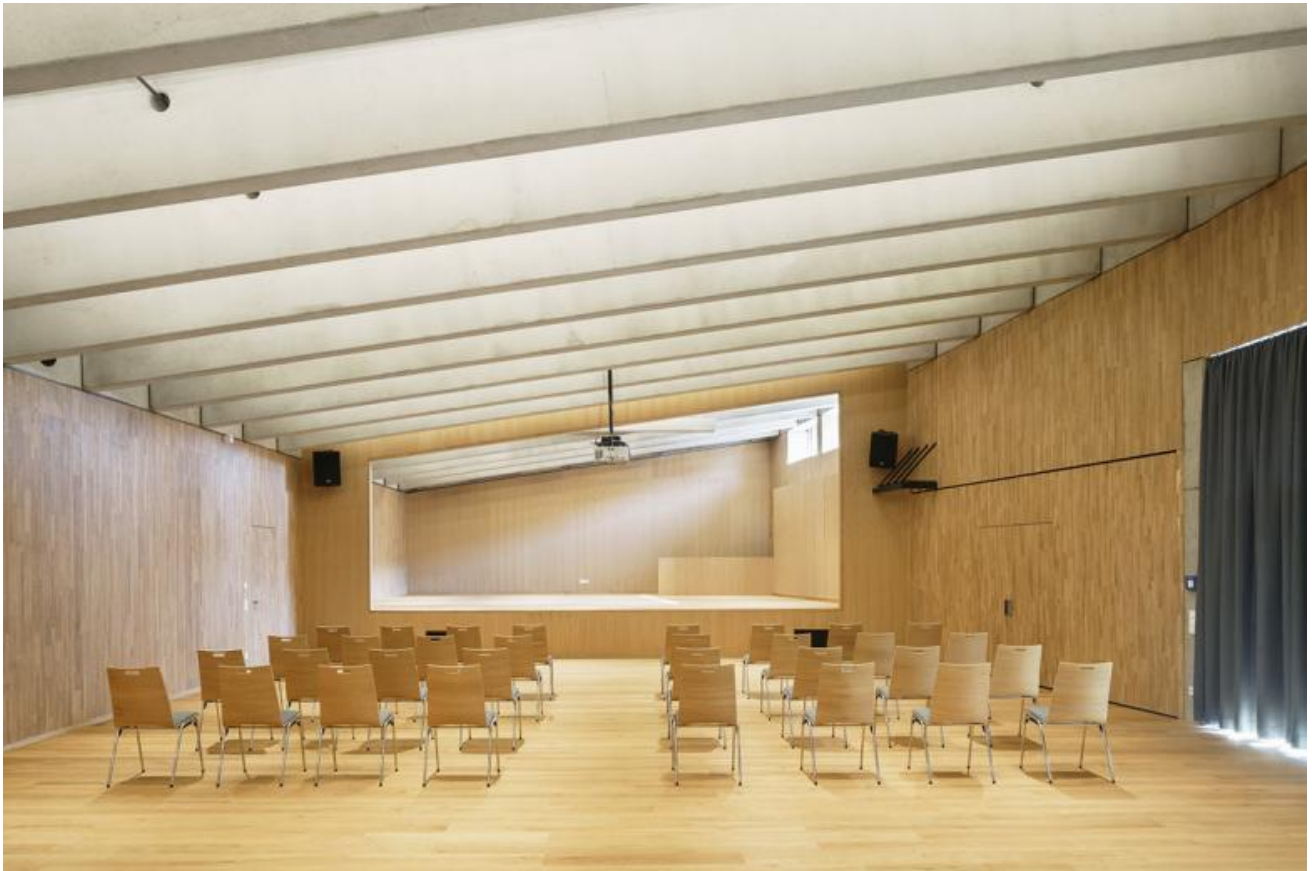
Harte Schale weicher Kern – Der Bürgersaal mit seiner Stammbetonfassade ist im Inneren mit Holz ausgekleidet, was für eine exzellente Raumakustik sorgt. (Foto: Sebastian Schels)
