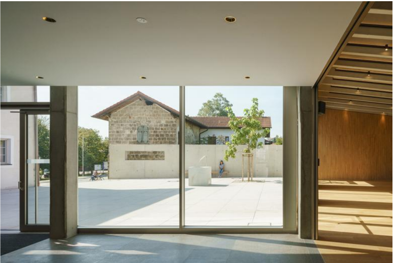
Zwischen Bestand und Bürgersaal entsteht ein großzügiger Vorplatz, der zum Verweilen einlädt. Das offene Foyer verbindet den neuen Saal mit dem Bestand. (Foto: Sebastian Schels)
