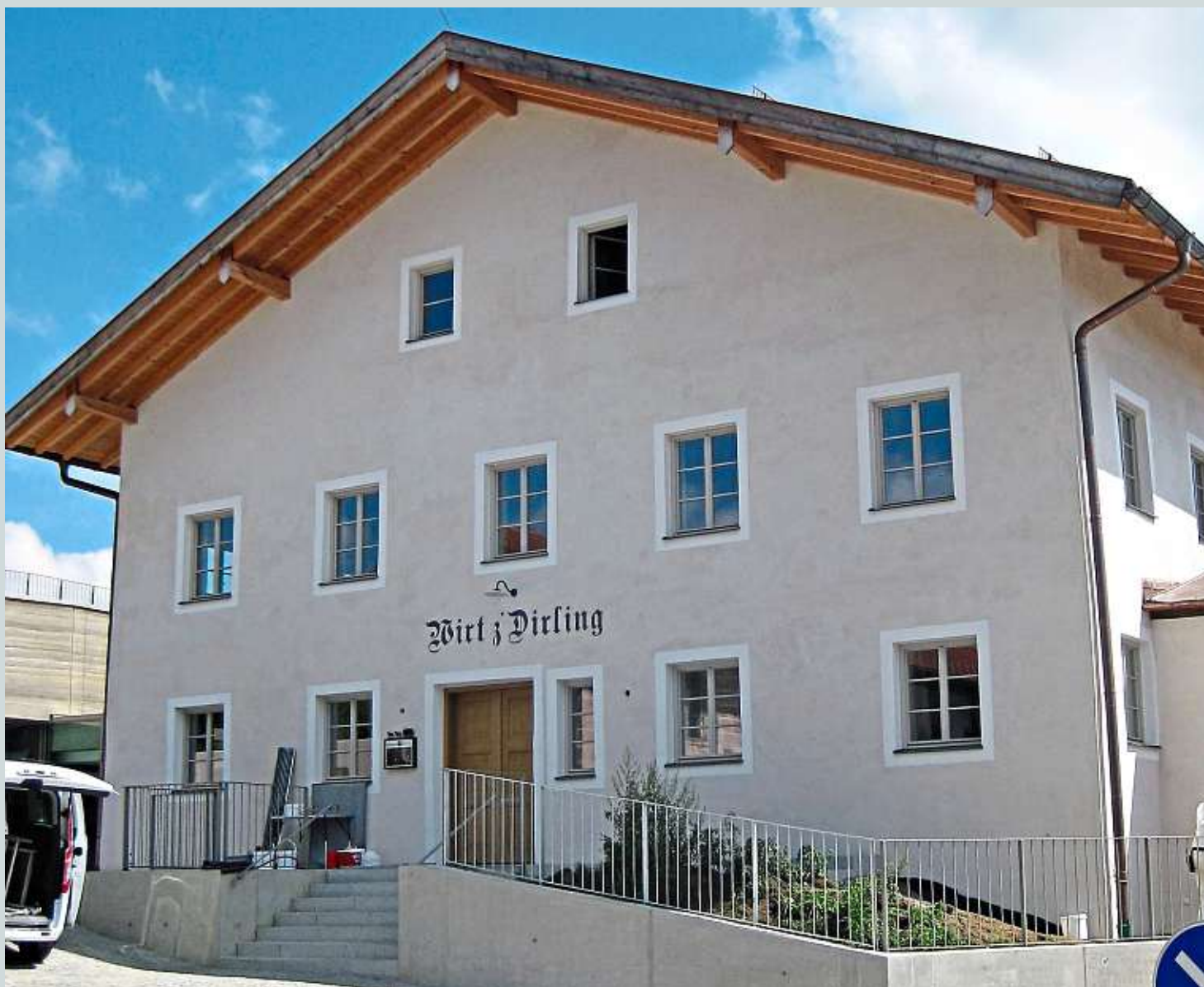
Letzte Malerarbeiten am sanierten, denkmalgeschützten neuen „Wirt z’Dirling“ – Eröffnung am Samstag, 15. August, ab 13 Uhr.
