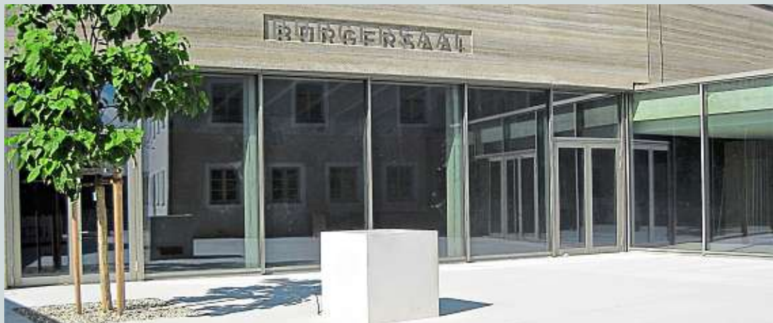
Der Neubau des Bürgersaals mit Blick in den Innenhof.
