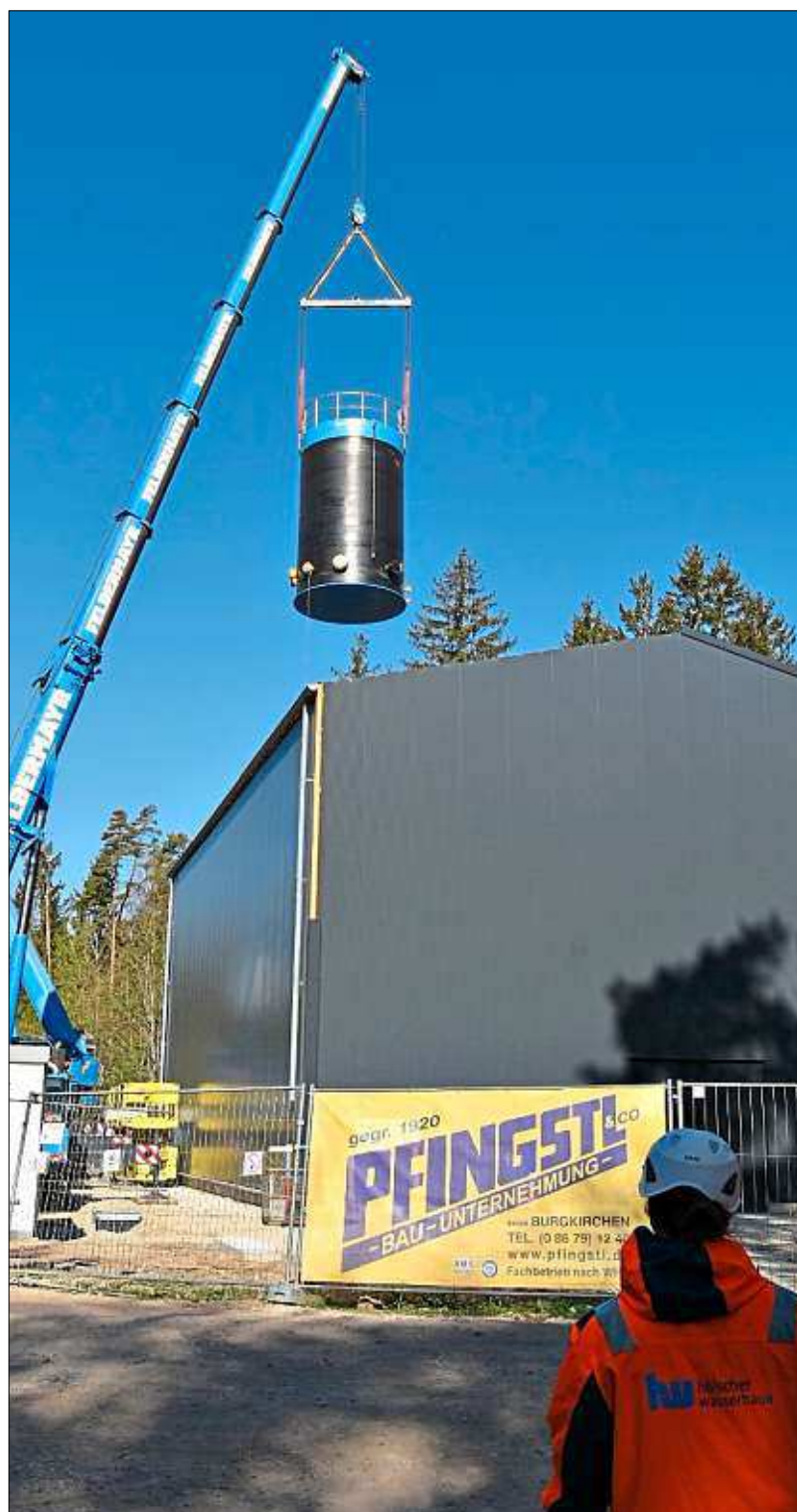
Die Anlieferung des Wassertanks war ein Spektakel, das sich auch die Arbeiter auf der Baustelle nicht entgehen ließen. – Fotos: Richter
