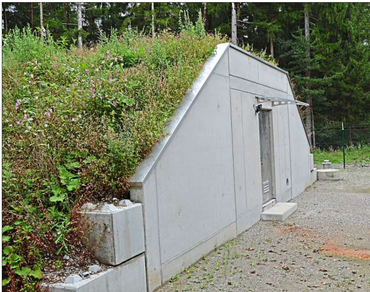
Die neuen Brunnenhäuschen sind äußerlich vollkommen fertig und eingezäunt. Der reichliche Regen in diesem Jahr hat dafür gesorgt, dass auf der Erdüberdeckung der Brunnenhäuschen das Gras bereits üppig wächst.
