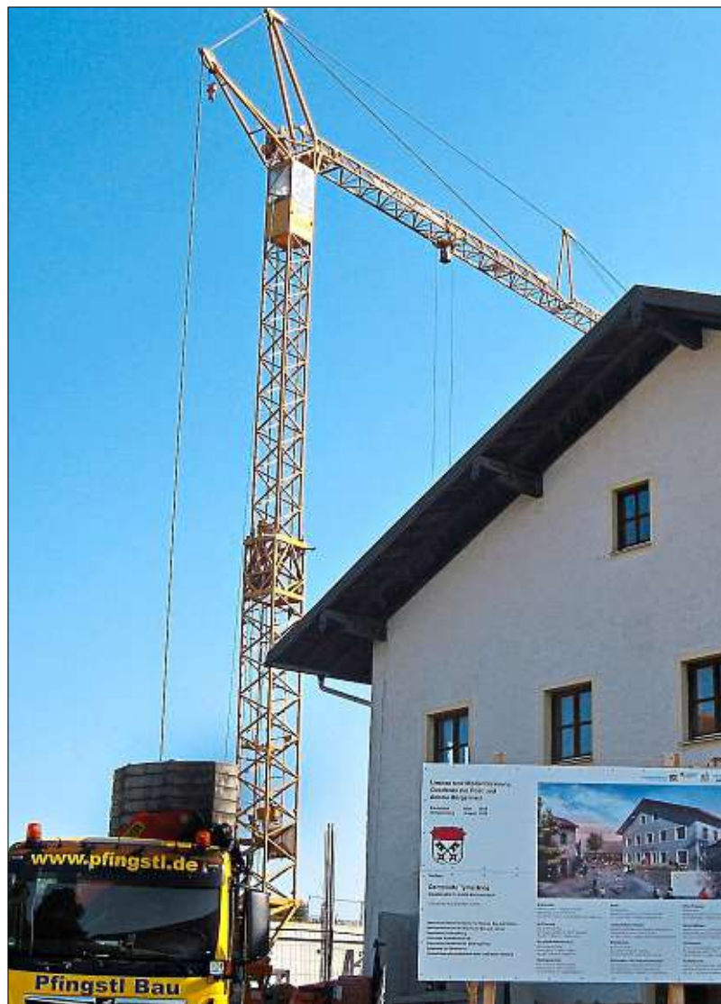
Großer gesellschaftliche Bedeutung sieht Gemeinderat Lothar Müller in der neuen Dorfmitte. Der denkmalgeschützte Gasthof wird derzeit aufwendig saniert. – Foto: Heckmann
